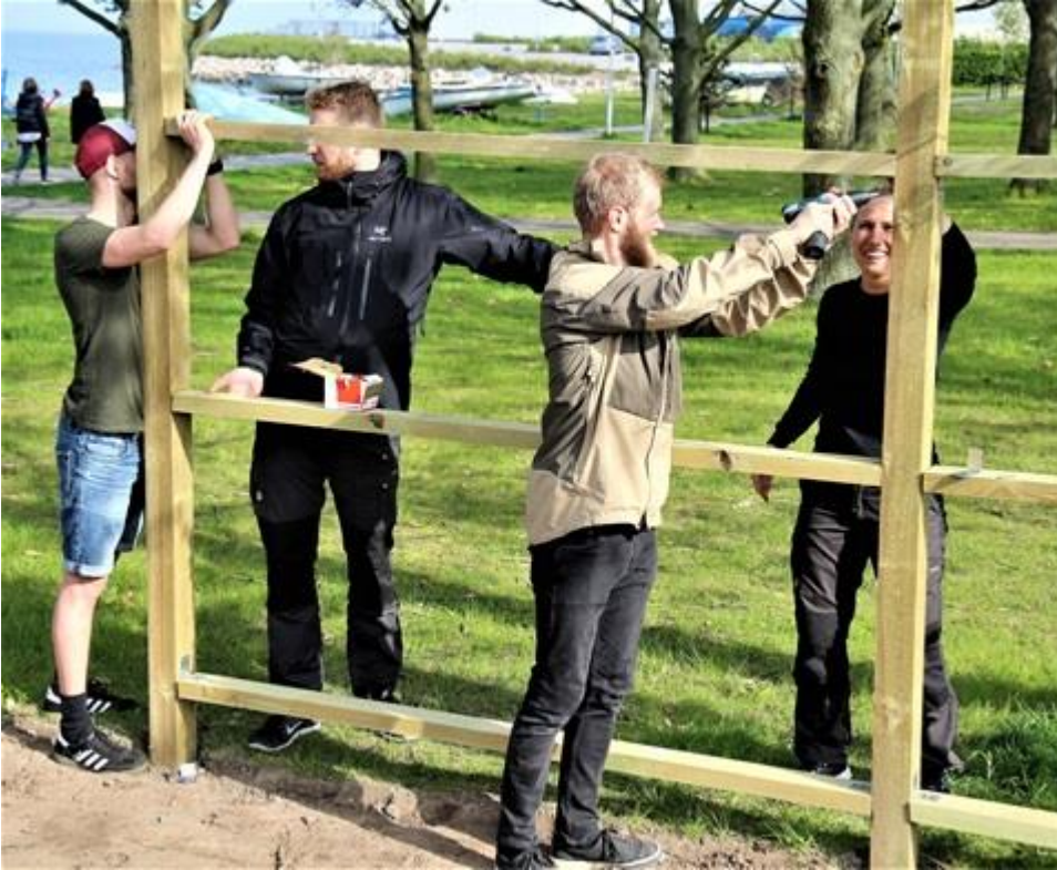
Der arbejdes på den nye tilbygning til klubhuset
